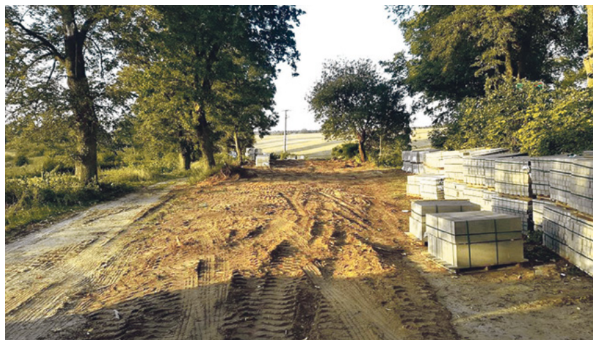
Budowa ścieżki rowerowej w Bartątku.
