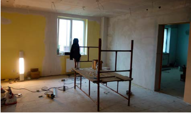
Trwa remont sali ślubów.
